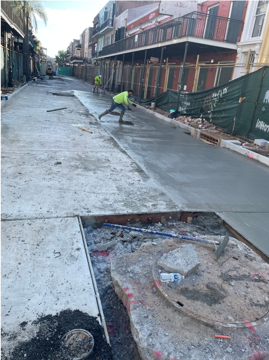
Concrete pour at Ursulines & Decatur
